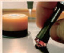
5. 職人の手によって丁寧に最新の注意 を払いながらカットして仕上げて行き ます。
