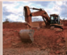
1 ショベルカーを使って地面を掘っていきます。
